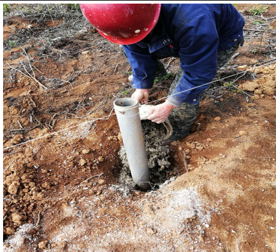
光伏东区 21#方阵混凝土灌注桩施工
