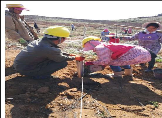
光伏东区 20#方阵混凝土灌注桩施工
