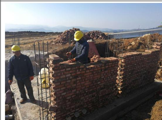
光伏区 18#、19#方阵箱逆变设备基础砖砌体砌筑
