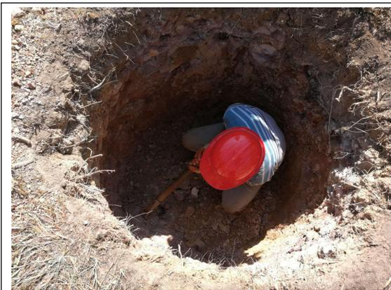
光伏东区架空集电线路杆塔基础土方
