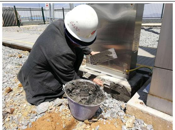
升压站室外检修箱设备基础修补
