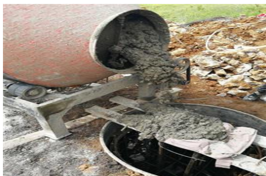
光伏东区集电线路 G6 塔基基础浇筑混凝土
