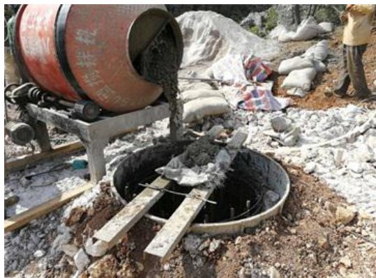
光伏东区集电线路 G8 塔基基础浇筑混凝土
