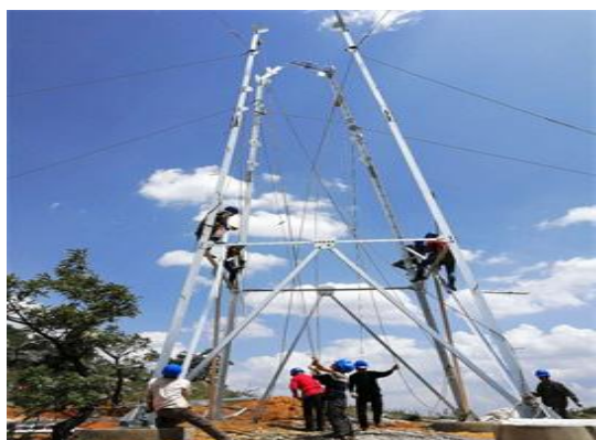
光伏东区集电线路 G7 铁塔组立
