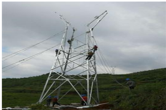
光伏东区集电线路 G6 铁塔组建
