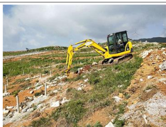
光伏东区 19#方阵场区拔桩施工
