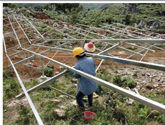
光伏东区 20#方阵支架安装
