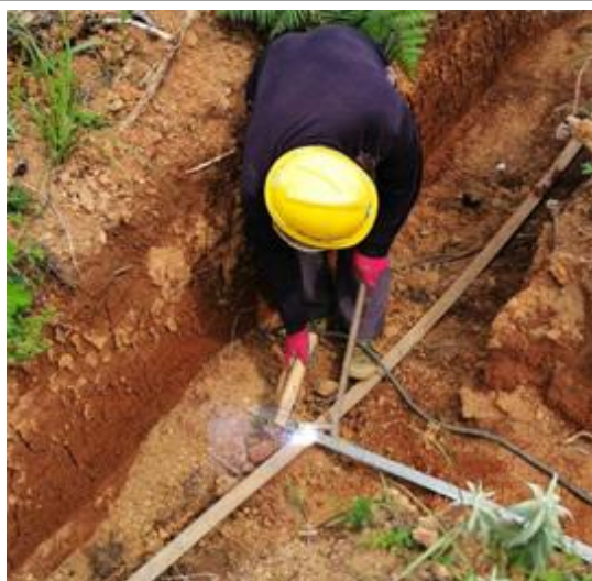
光伏东区场区接地扁铁焊接
