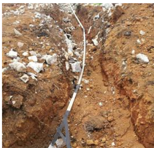
光伏东区场区接地扁铁焊接
