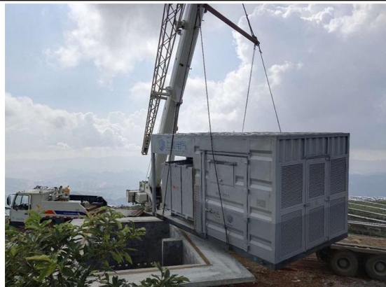
光伏东区 25 号方阵箱逆变设备更换
