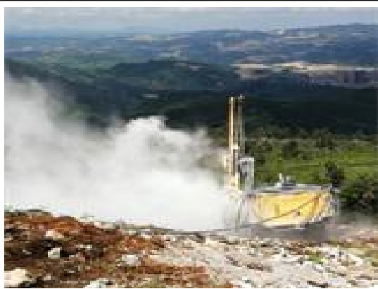
光伏东区场区桩机钻孔
