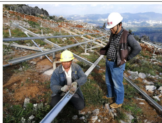
光伏东区 17 号方阵支架安装
