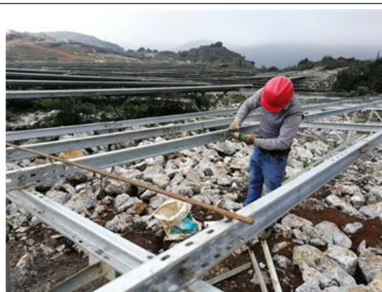
光伏东区 20 号方阵支架安装
