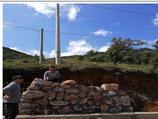
10kV 线路 39 号杆周边砌筑挡土墙
