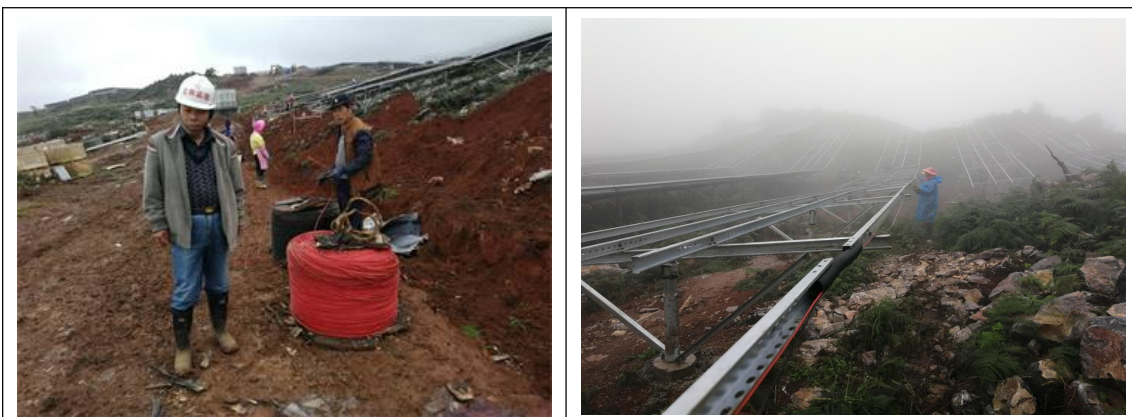
光伏东区 20 号方阵直流电缆敷设
