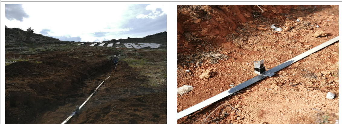
光伏东区 21 号方阵场区环形接地施工
