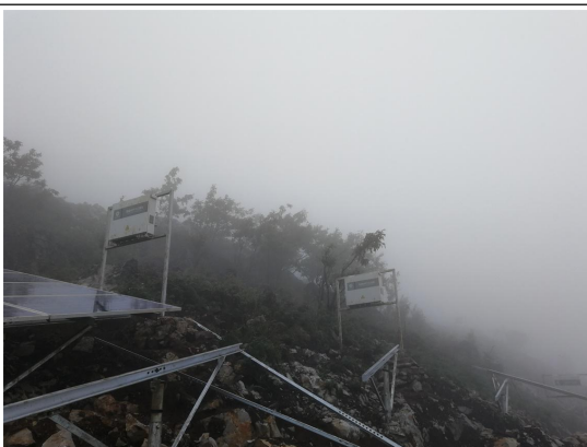
光伏东区 21 号方阵汇流箱安装
