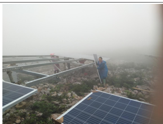
光伏东区 20 号方阵组件安装
