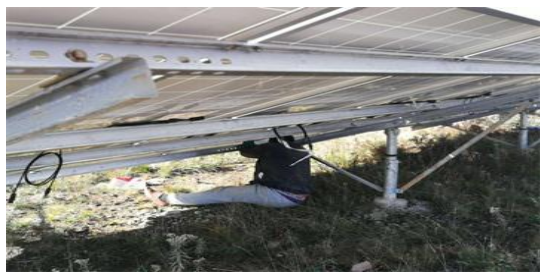
光伏东区 18 号方阵组件安装
