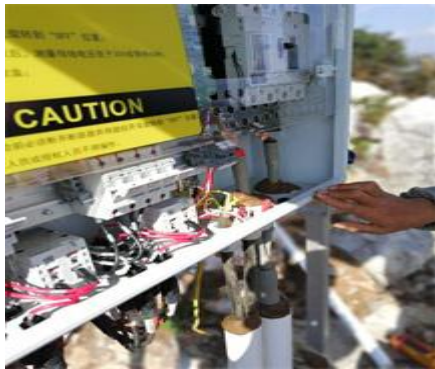
光伏区 20 号方阵汇流箱电缆接线、穿 线管口处封堵
