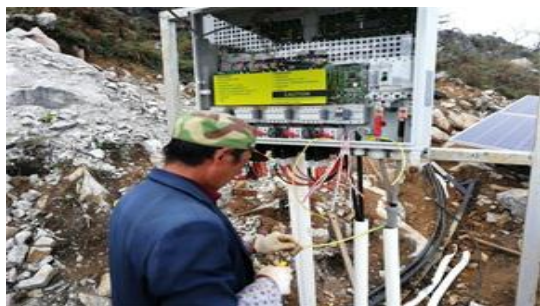
光伏区 21 号方阵汇流箱电缆接线以及 接地线连接
