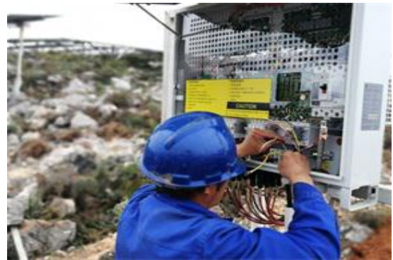
光伏区 20 号方阵汇流箱电缆接线以及 接地线连接
