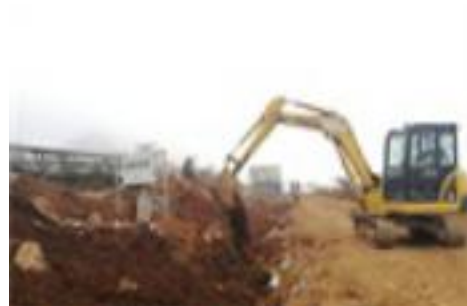
光伏东区 20 号方阵电缆沟土方回填
