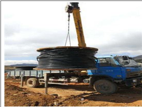
光伏东区吊运电缆
