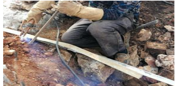
光伏东区 20 号方阵场区接地扁铁焊接
