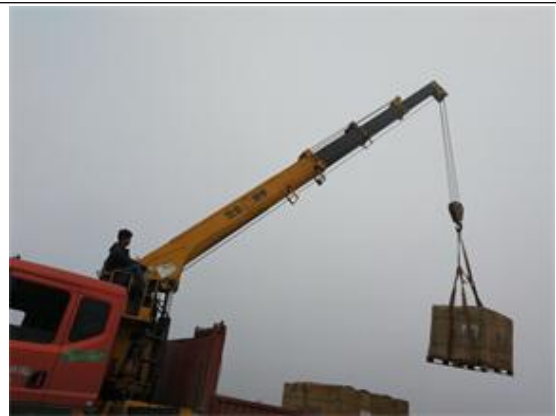
光伏东区材料吊运
