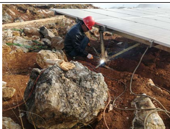
光伏东区接地网完善
