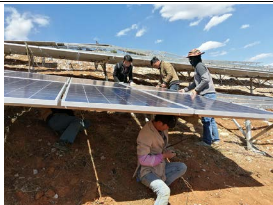
16 号方阵后补 1MW 组件倒运及组件安装
