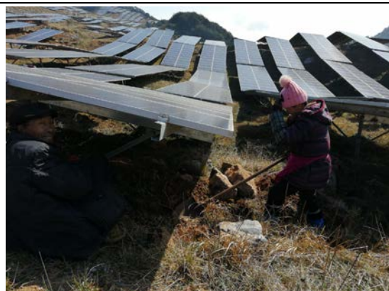
光伏东南区接地网完善
