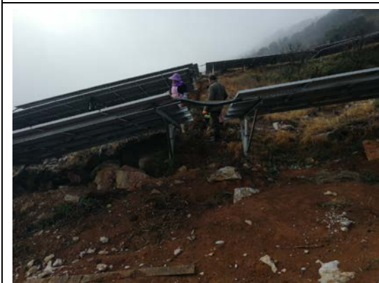
对光伏区北区接地网完善
