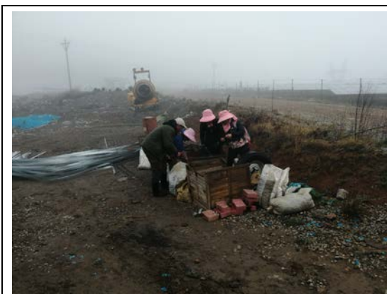
光伏区南区消缺
