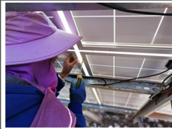
光伏东区 17 号方阵同一组组件相邻光伏板跨接地线安装
