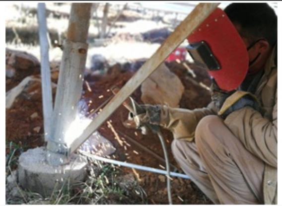
光伏东区 20 号方阵场区接地扁铁焊接
