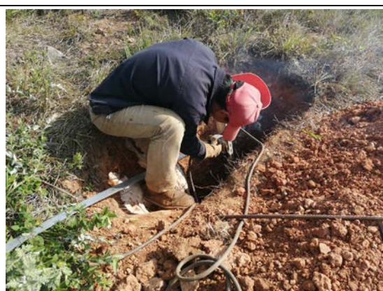
光伏区接地降阻施工
