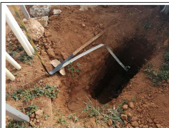
光伏区接地降阻施工
