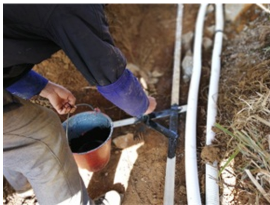
光伏东区 20 号方阵场区接地扁铁焊接 处刷防腐漆
