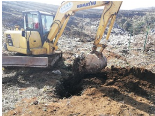
光伏东区 18 号方阵场区接地环网沟土 方回填
