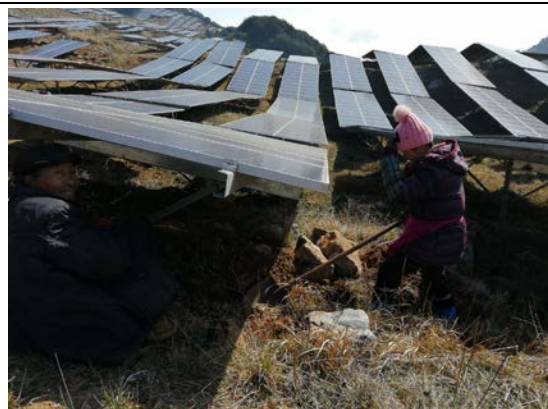
光伏东南区接地网完善
