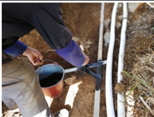
光伏东区 20 号方阵场区接地扁铁焊接 处刷防腐漆
