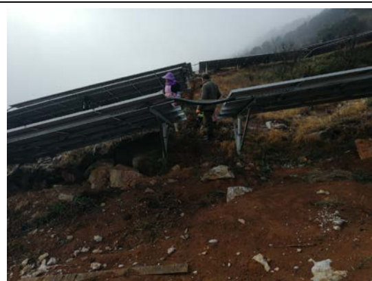
对光伏区北区接地网完善
