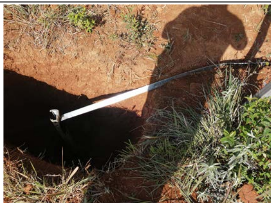
光伏区接地降阻施工
