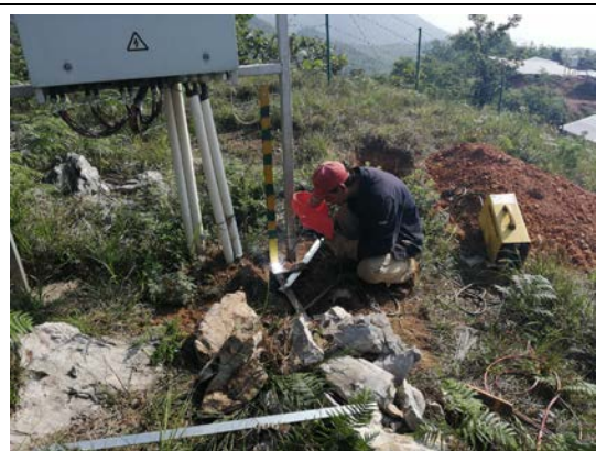
光伏区接地降阻施工
