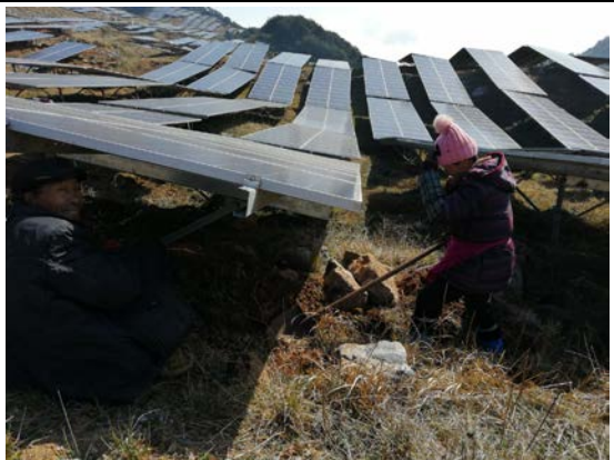
光伏东南区接地网完善
