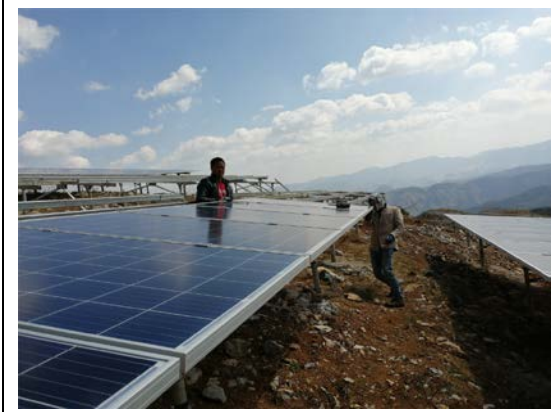
光伏区接地降阻接地电阻检查
