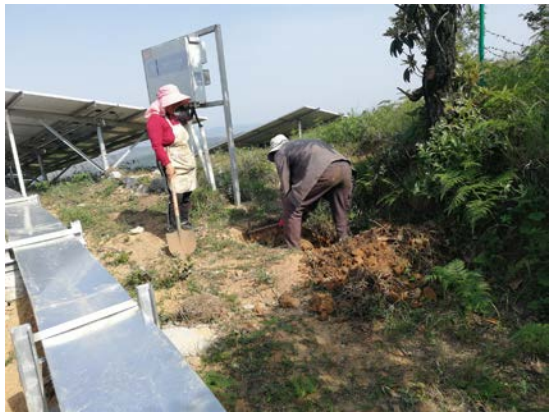
光伏区接地降阻井开挖
