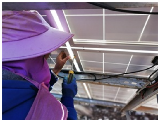
光伏东区 17 号方阵同一组组件相邻光伏板跨接地线安装
