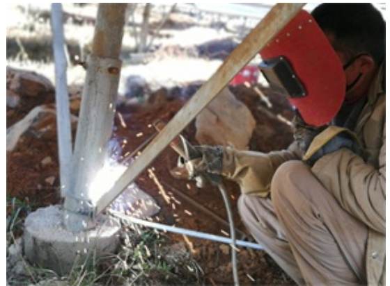
光伏东区 20 号方阵场区接地扁铁焊接
