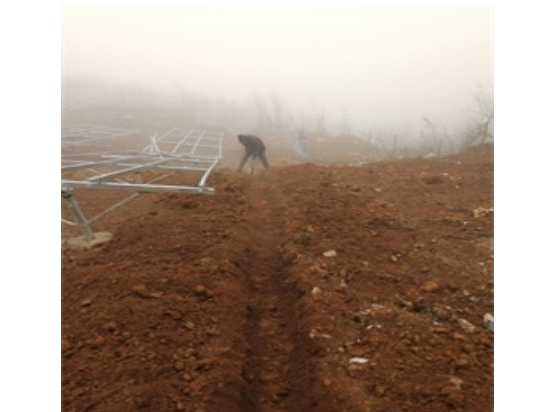
光伏区接地降阻井开挖
