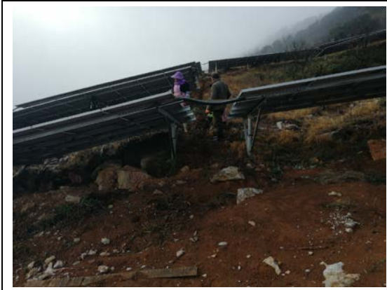
对光伏区北区接地网完善
