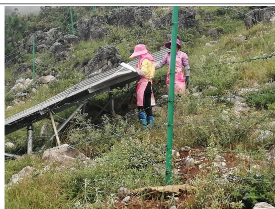
光伏区接地降阻施工
