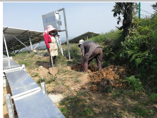
光伏区接地降阻井开挖
