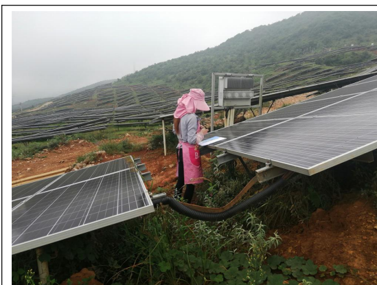
光伏区接地降阻施工
