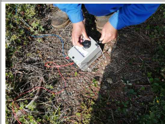
光伏区接地降阻接地电阻检查
