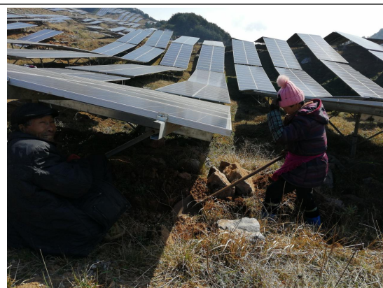
光伏东南区接地网完善
