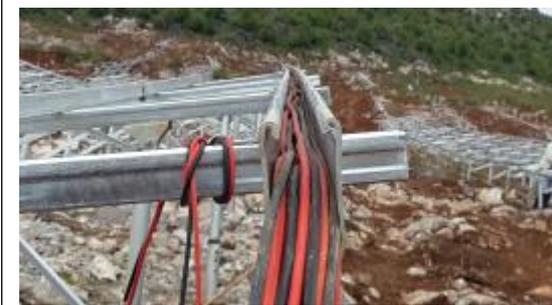
光伏区 13 号方阵直流电缆敷设施工
