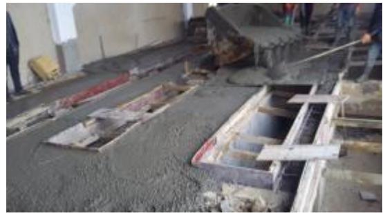
升压站电气综合楼室内电缆沟压顶梁浇筑混凝土
