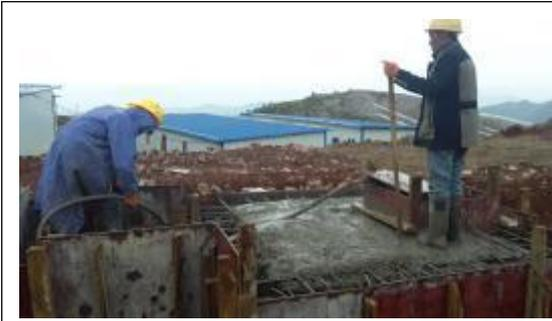
升压站室外调节池基础浇筑混凝土
