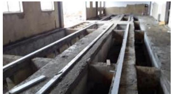
升压站电气综合楼室内电缆沟槽钢焊接施工
