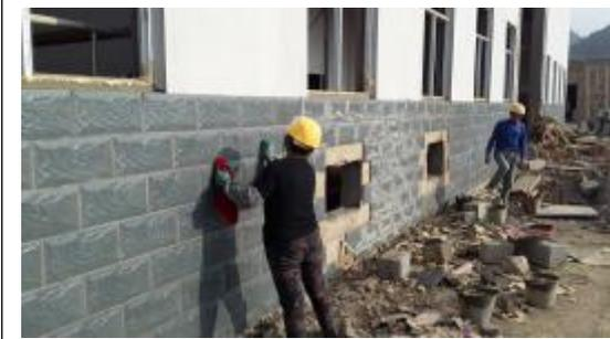
升压站电气综合楼室外墙面瓷砖粘贴施工
