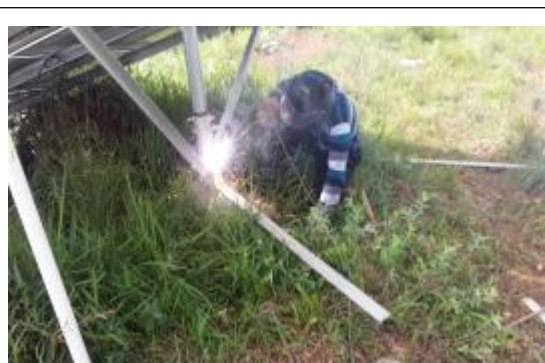
光伏区 15#方阵支架接地扁铁焊接
