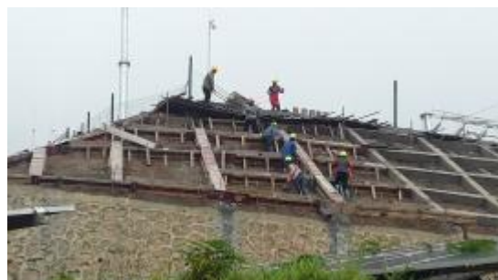
升压站护坡表层框架浇筑混凝土
