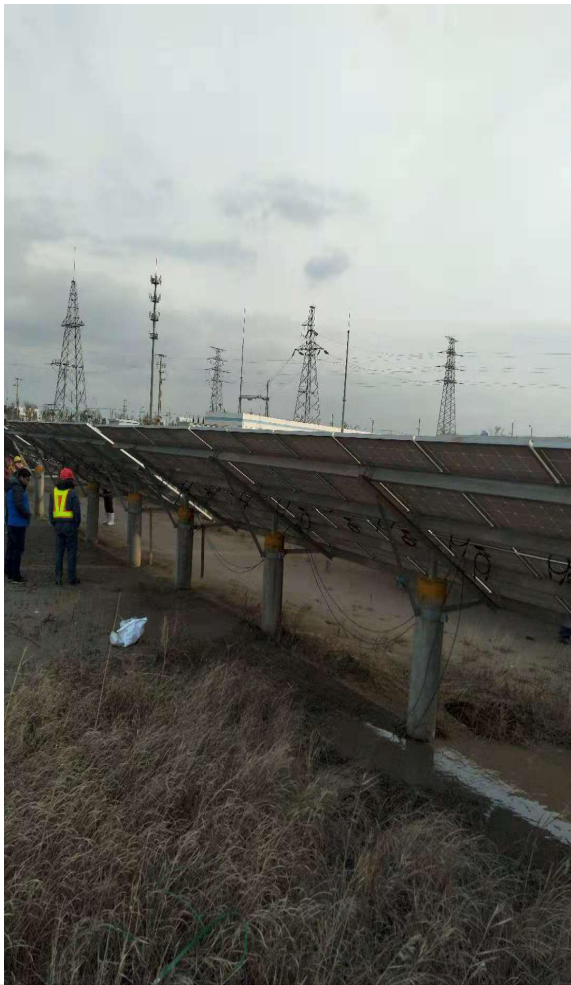
检查组件安装
