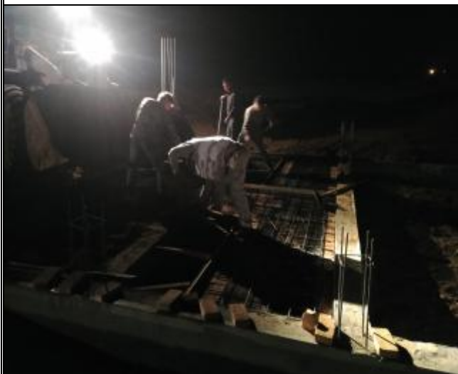
箱逆变基础夜间浇筑
