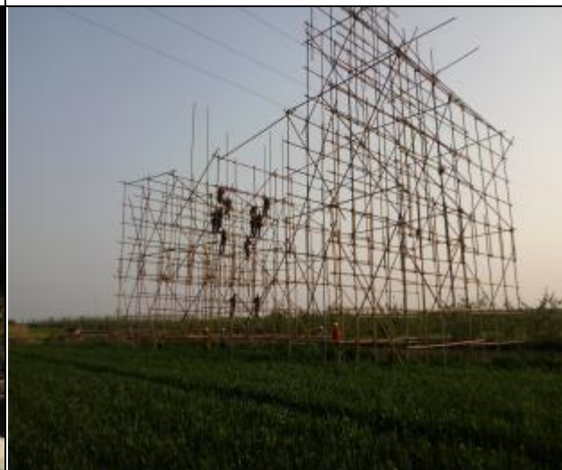
外线跨越线路支架搭设
