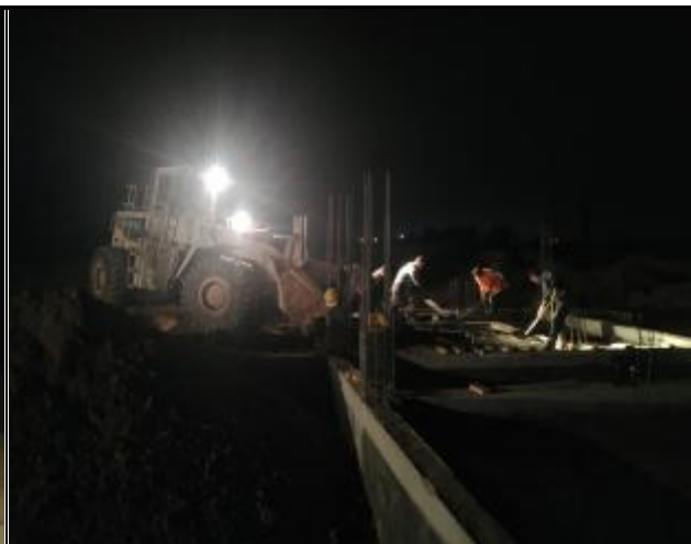
综合楼夜间施工
