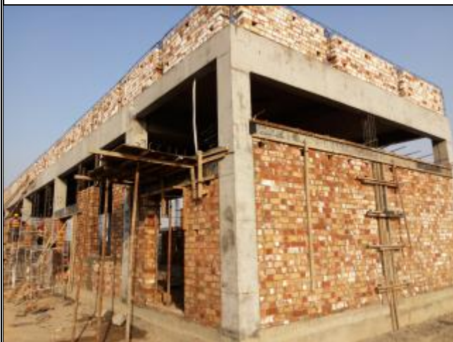
电控室外墙砌筑
