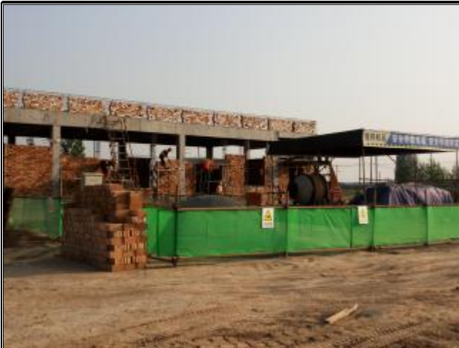
厂前区文明施工整改情况
