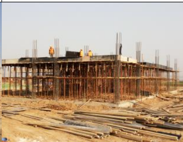
综合楼一层绑钢筋支模
