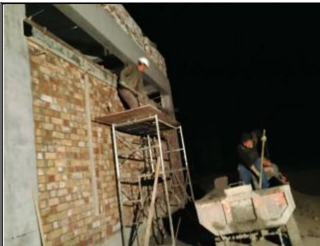
电控室夜间施工
