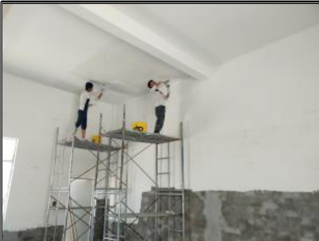
电控室刮腻子
