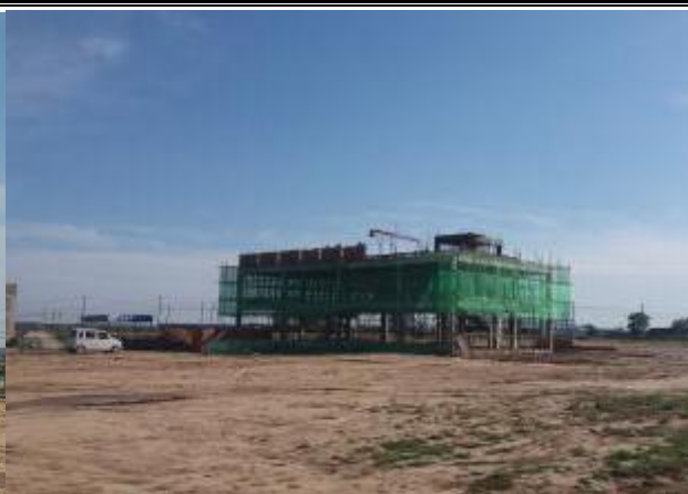
综合楼形象进度
