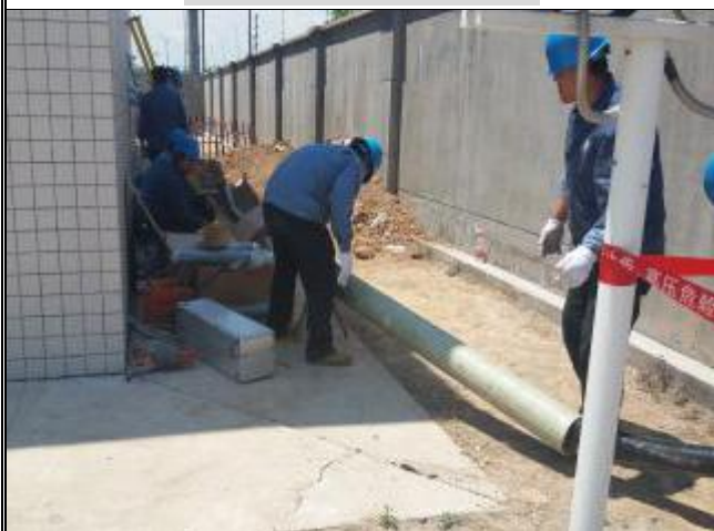
刘家卓变电站内电缆敷设接线
