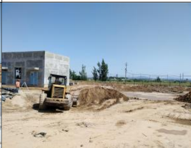
SVG基础开挖
