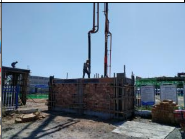
门卫室及伸缩门洞浇筑
