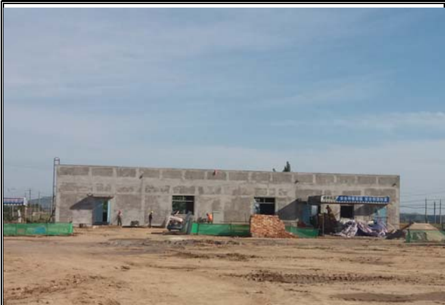
电控室形象进度
