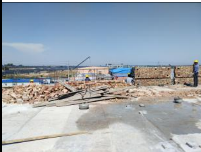
综合楼女儿墙砌筑
