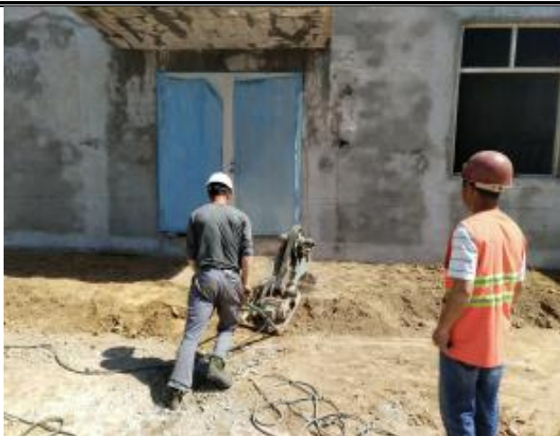
电控室散水基础夯实
