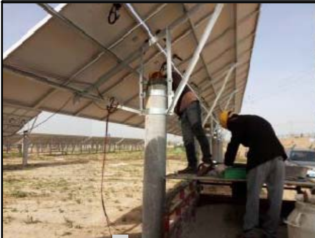
光伏电缆敷设
