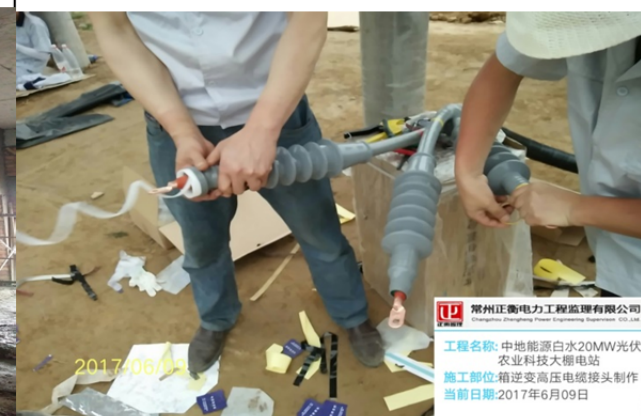
箱逆变高压电缆头制作
