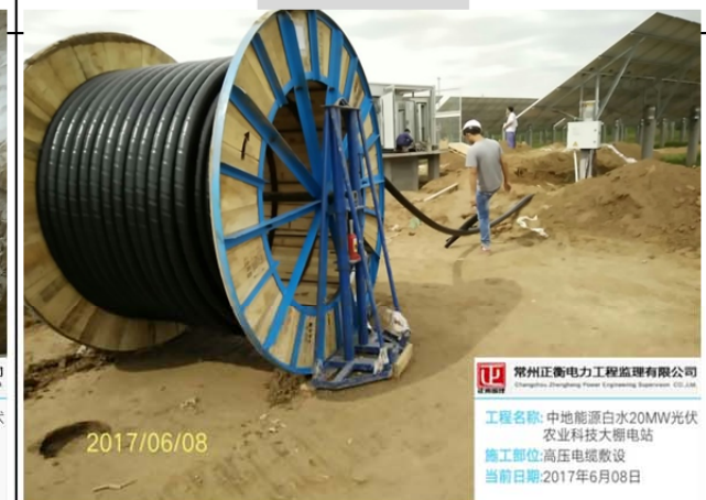
高压电缆敷设
