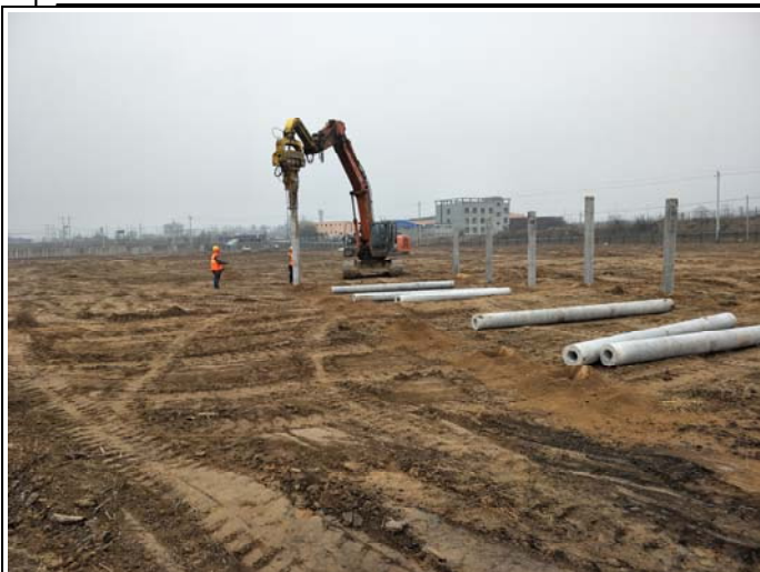
PHC桩打桩施工
