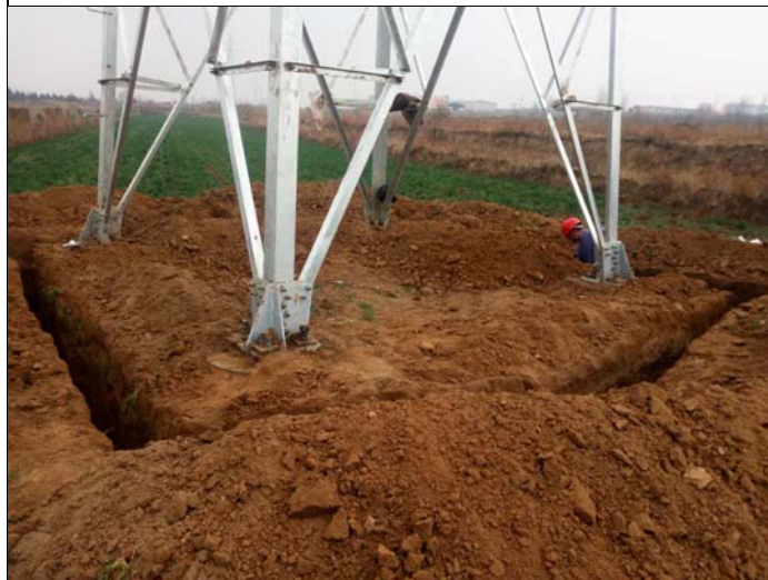
外线基础接地施工
