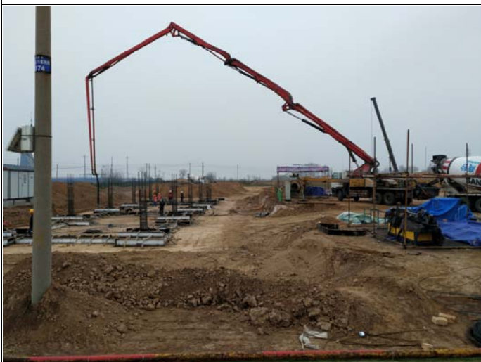
PHC桩打桩施工
