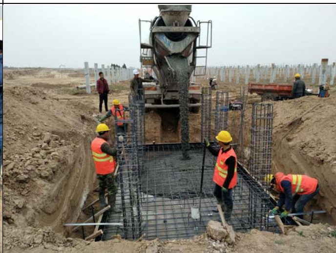
箱逆变基础浇筑混凝土
