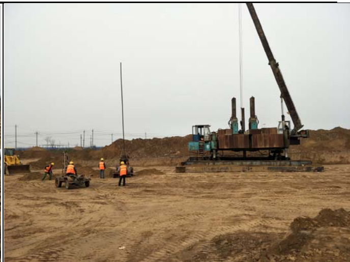
综合楼地基处理施工
