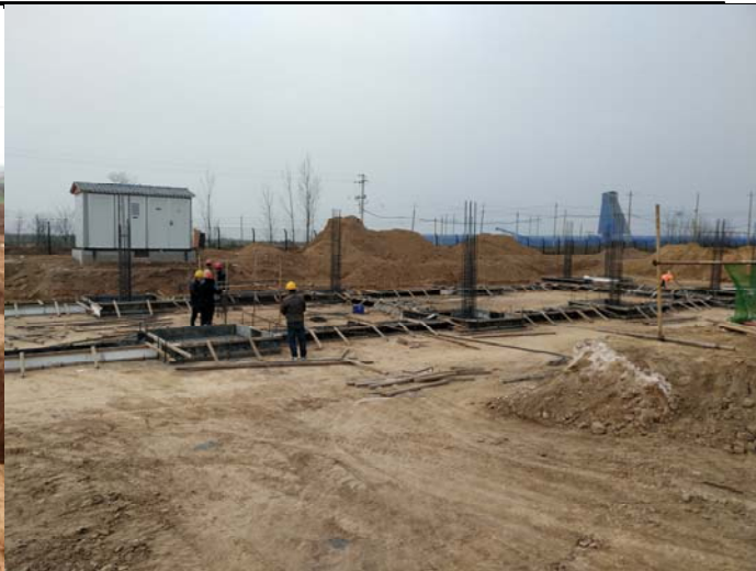
电控室地板浇筑完成
