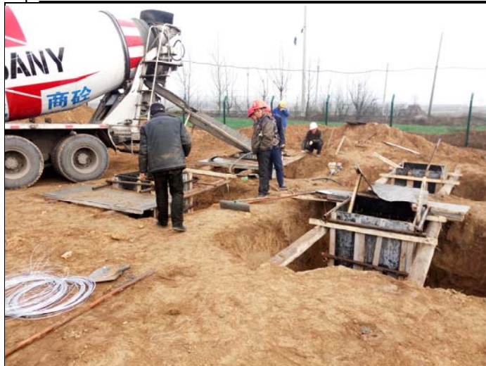
外线基础浇筑混凝土
