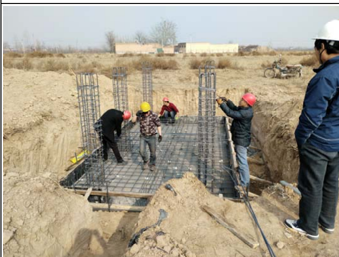
箱逆变基础绑钢筋
