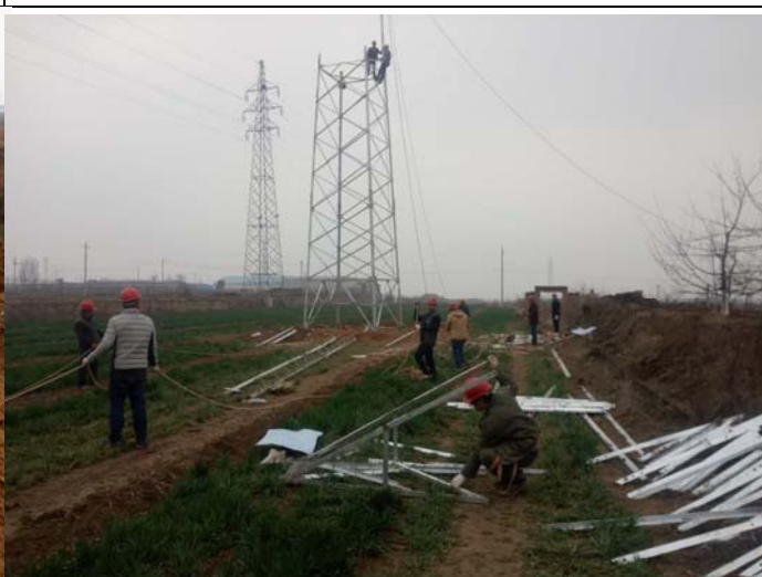
外线组立铁塔
