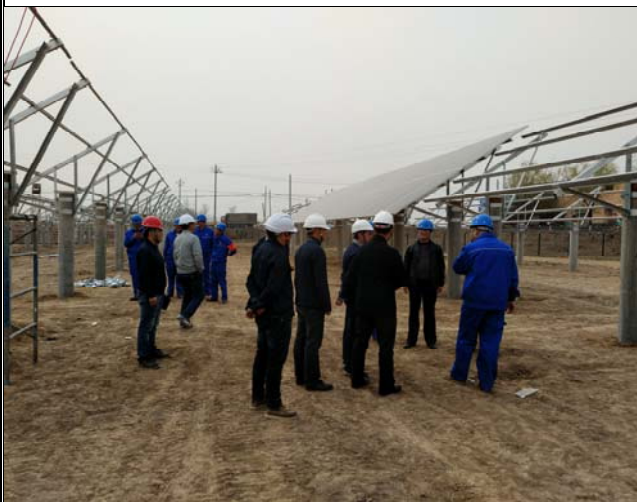
领导检查工地
