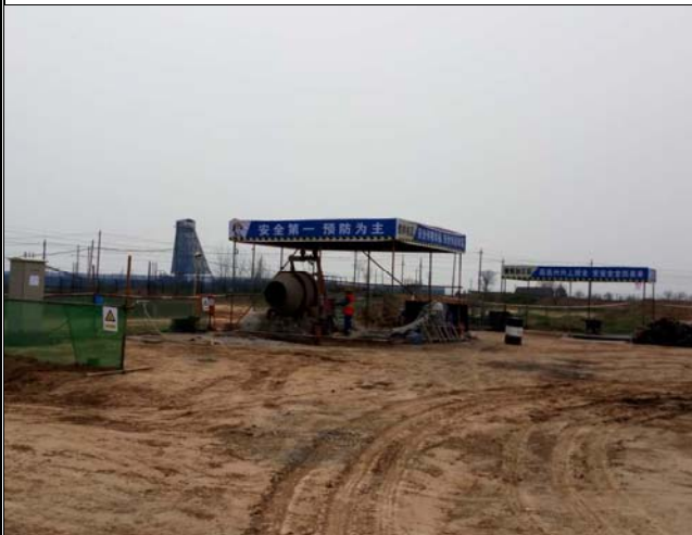
文明施工情况
