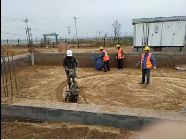
电控楼基础回填并夯实
