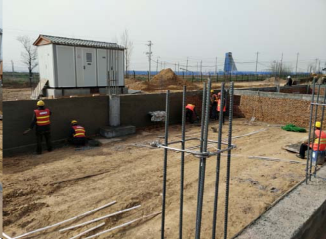
电控室基础墙抹灰
