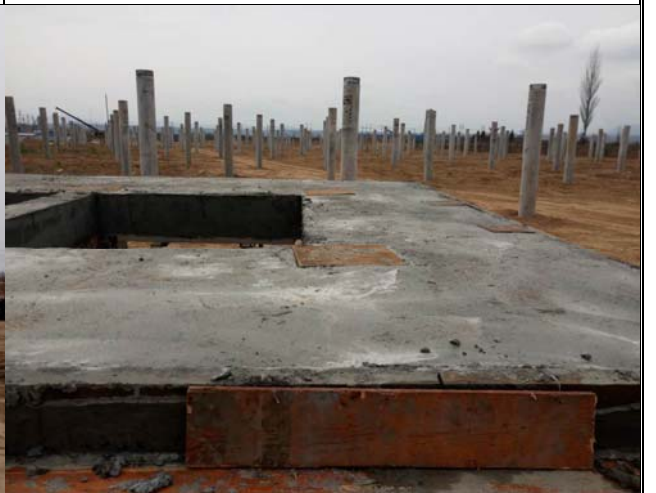
箱逆变平台拆模
