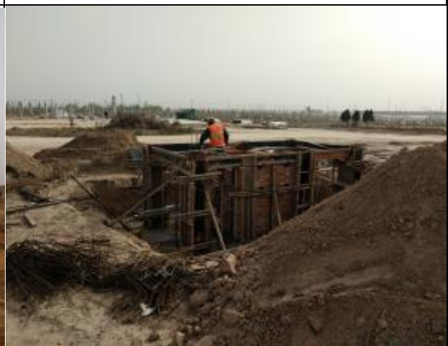
箱逆变基础支模
