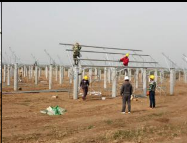
东北区支架安装
