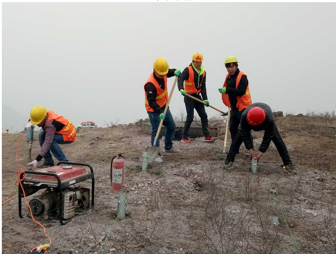
地锚桩浇筑作业
