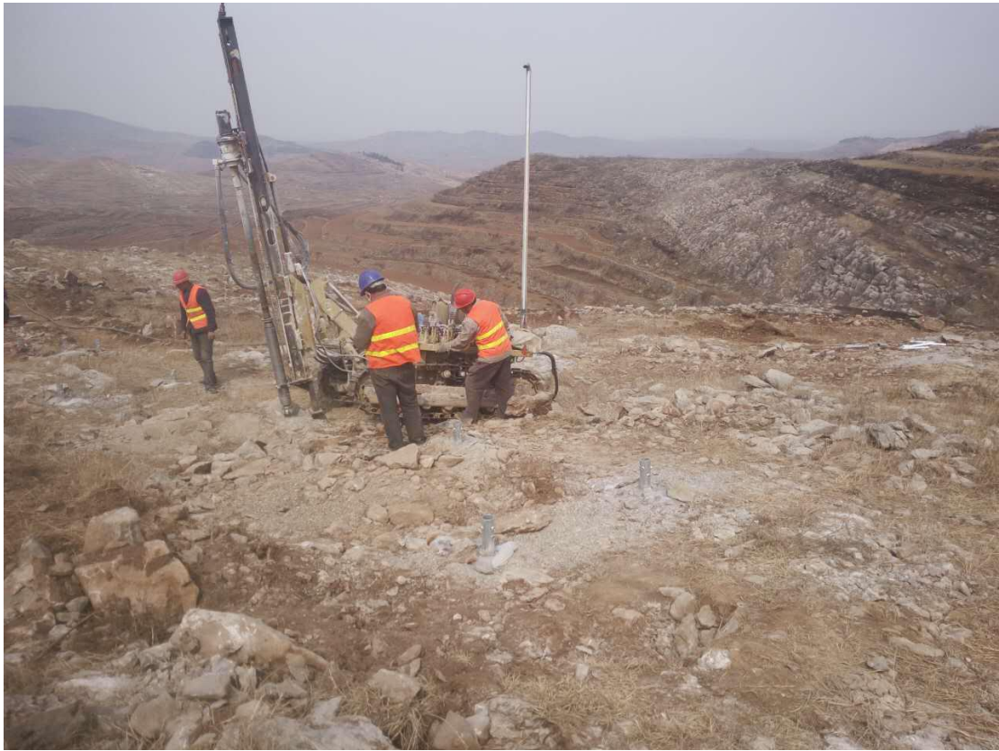
地锚桩基础整改
