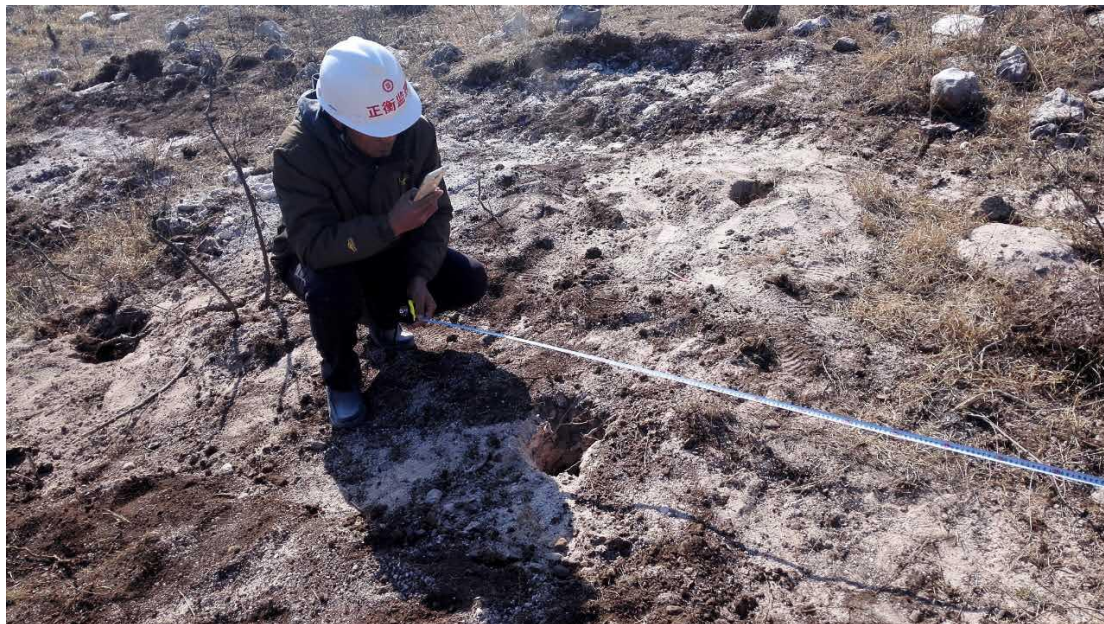
监理人员现场抽检
