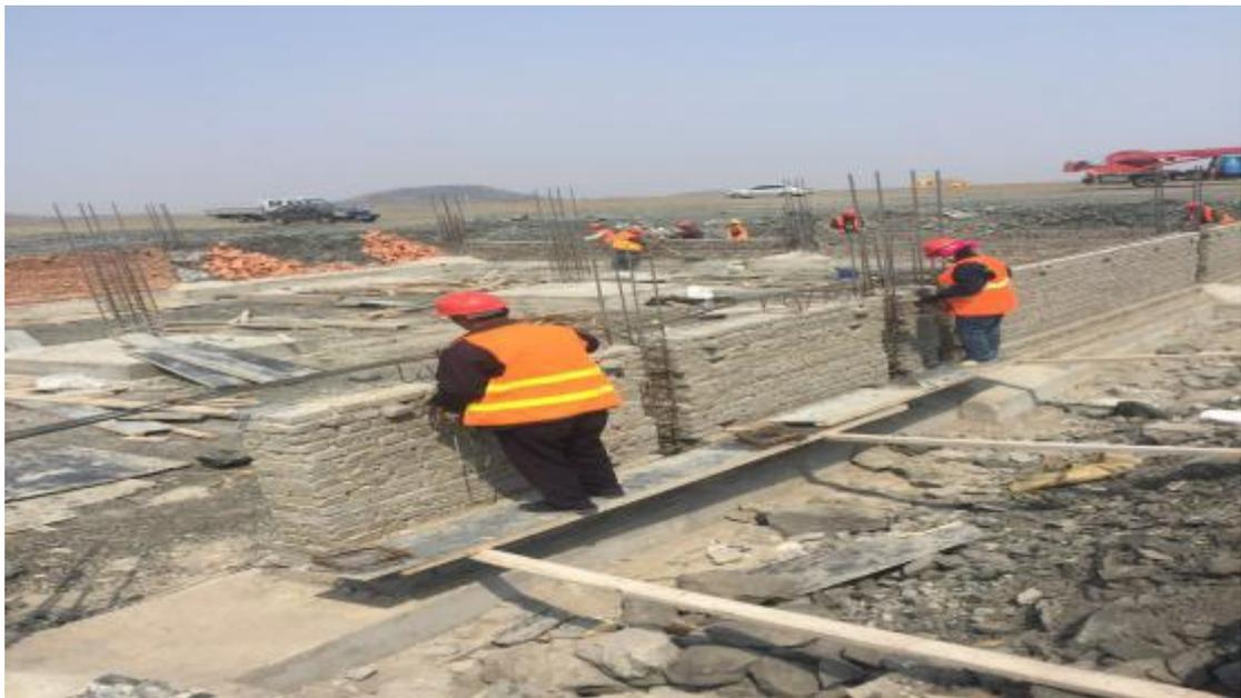
配电室圈梁、构造柱钢筋绑扎
