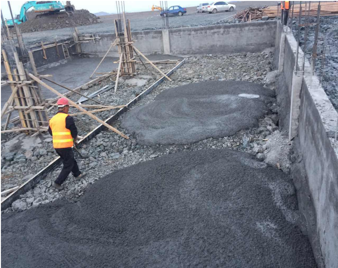
配电楼室内设备基础垫层浇筑
