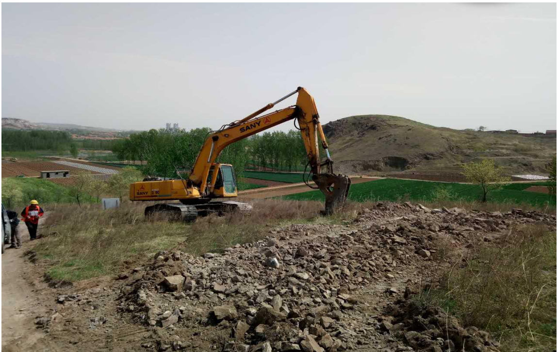
箱变基础开挖
