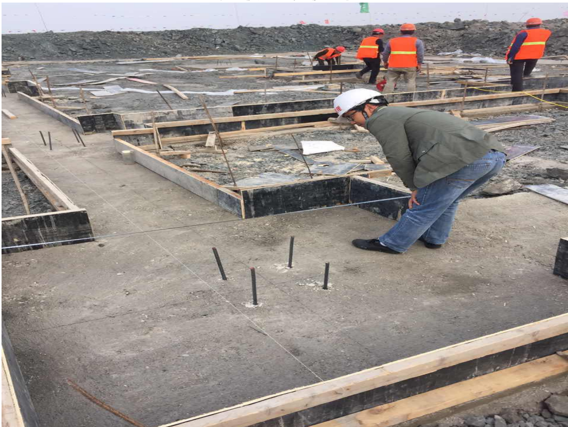
综合楼基础支模验收
