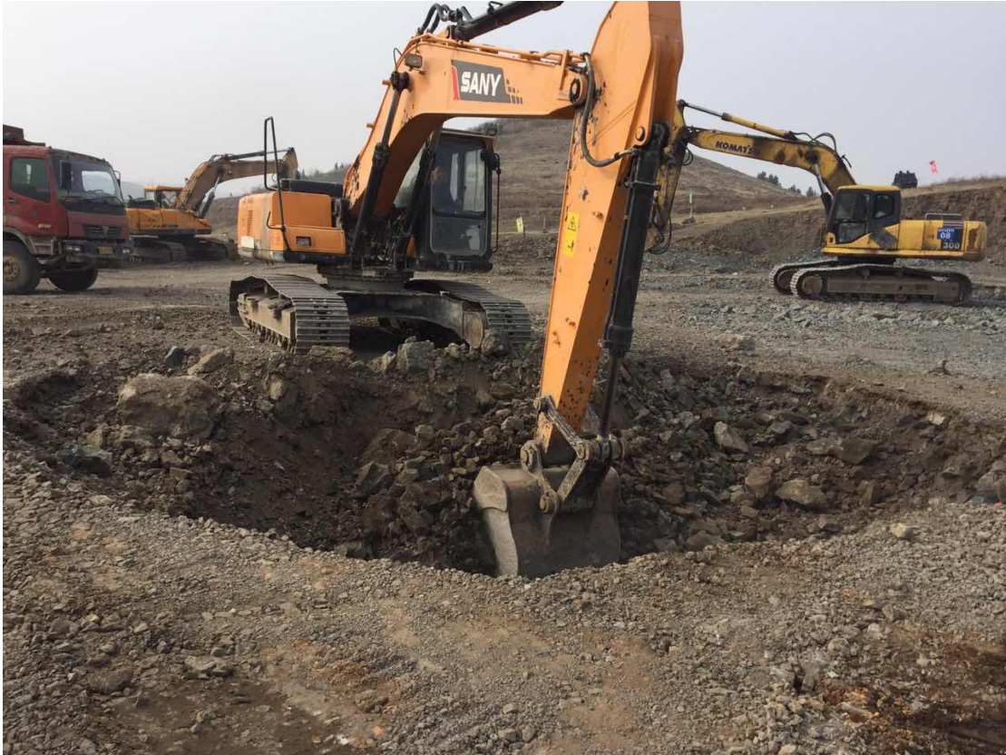
避雷针基础开挖
