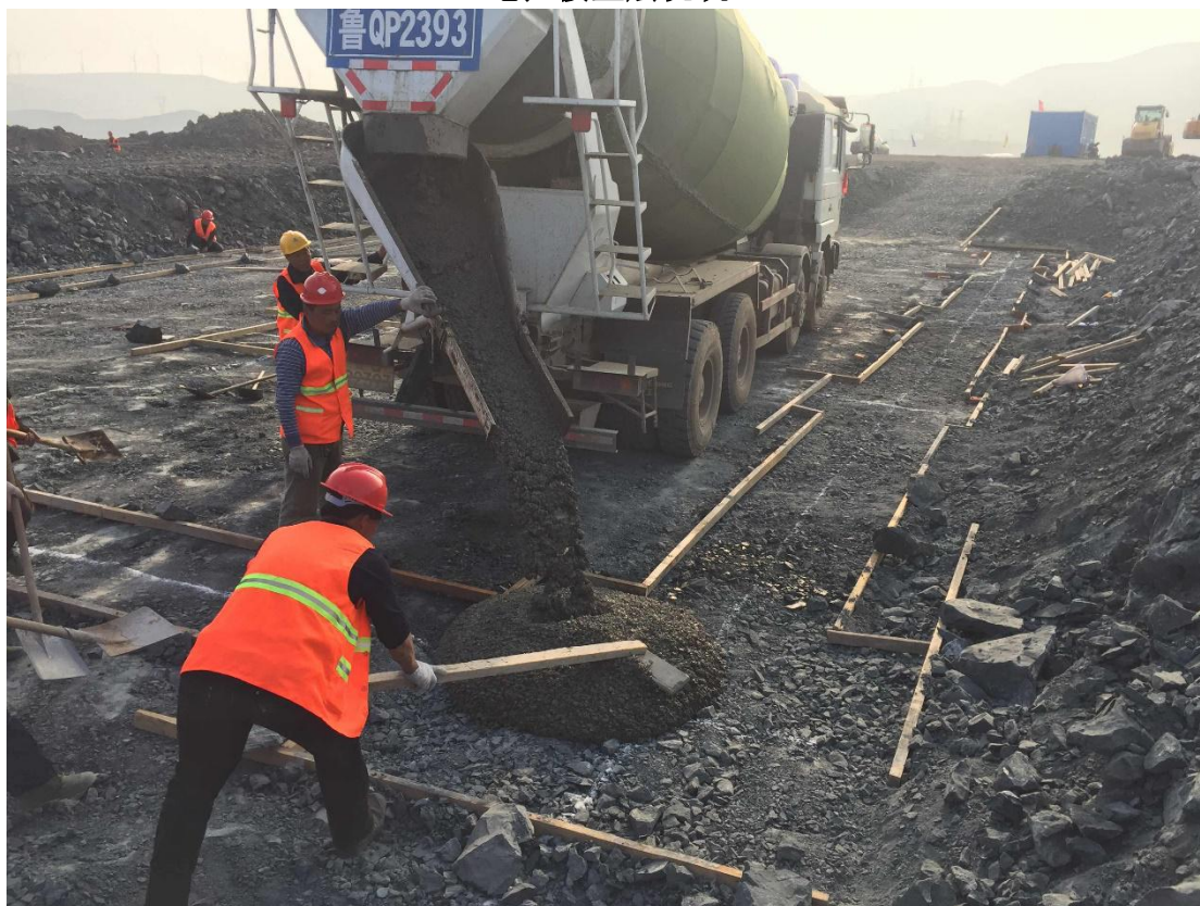
电控楼垫层浇筑
