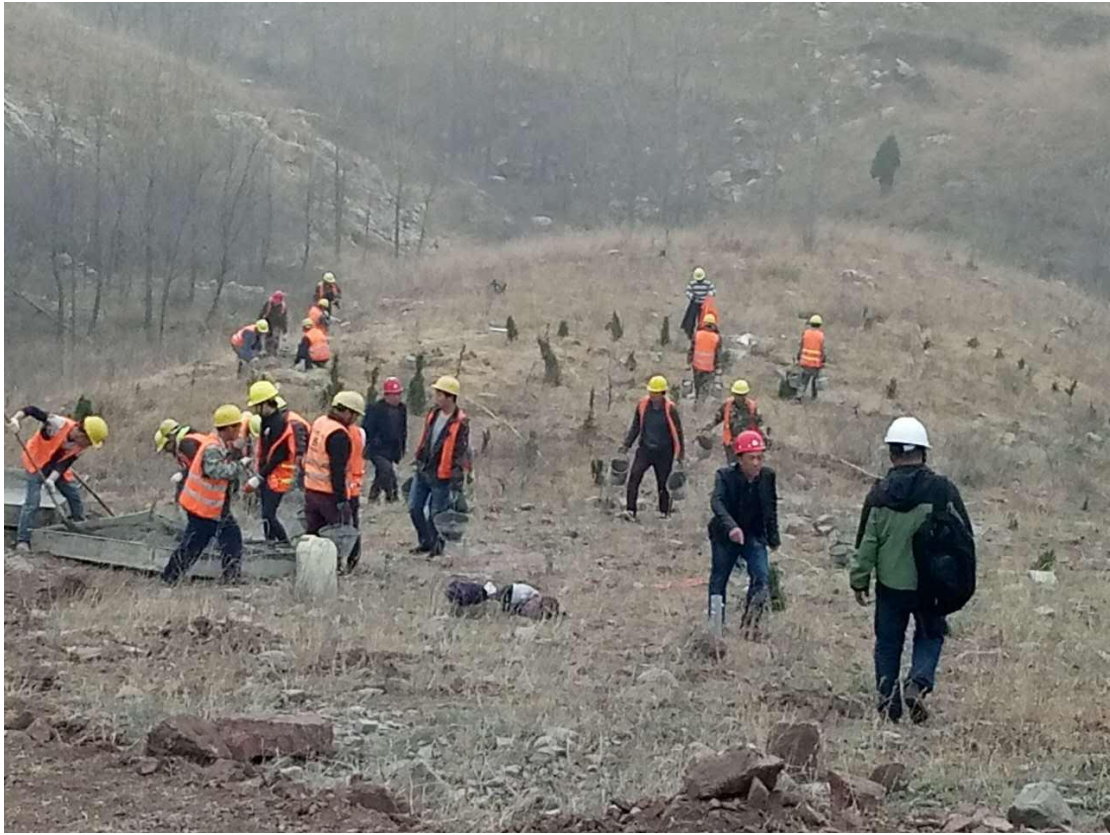
固定支架基础浇筑
