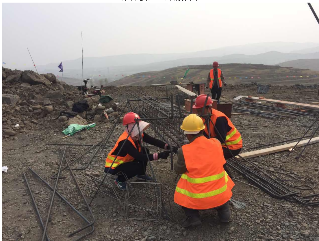
综合楼基础钢筋邦扎
