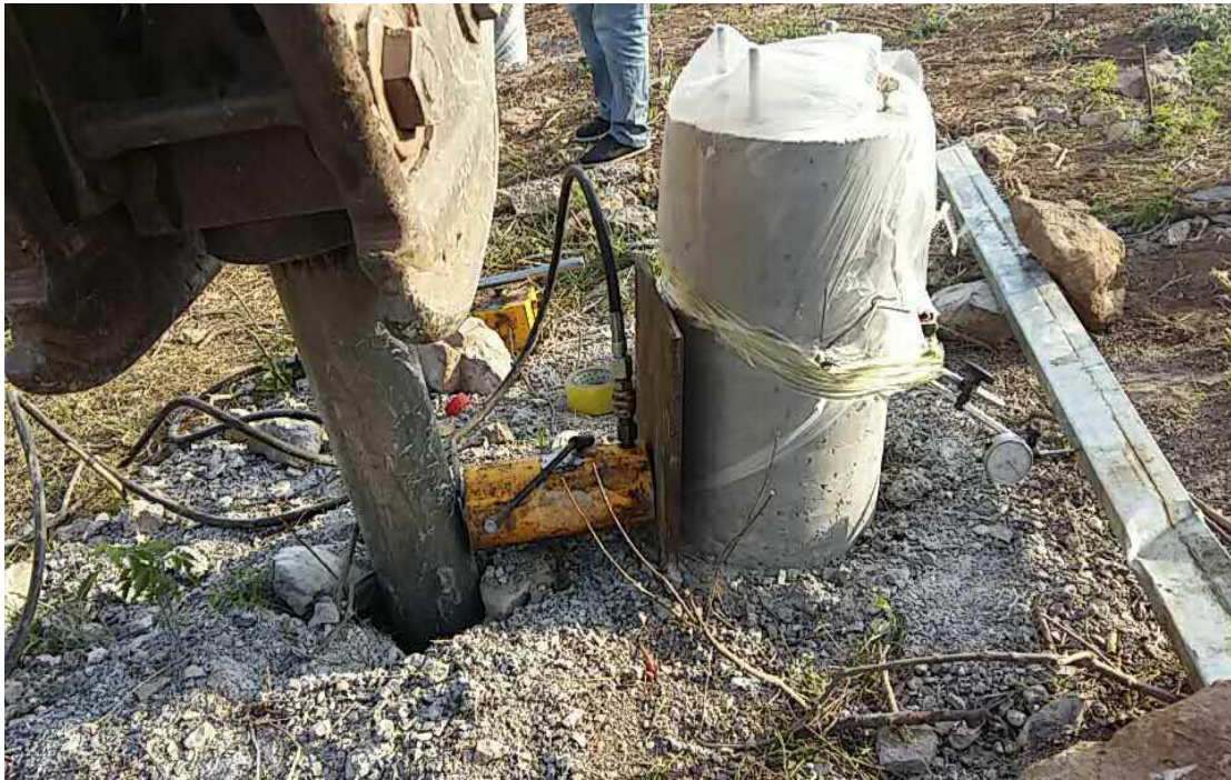
跟踪支架基础水平位移试验
