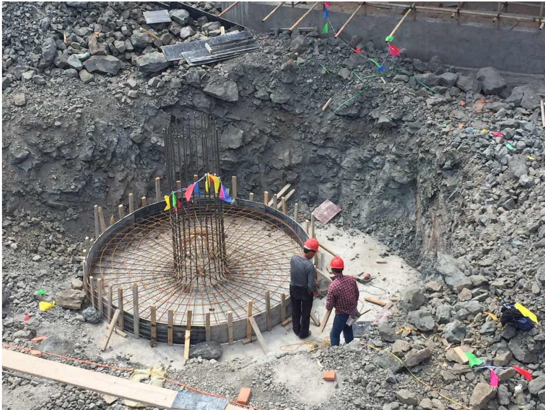
避雷针基础钢筋绑扎
