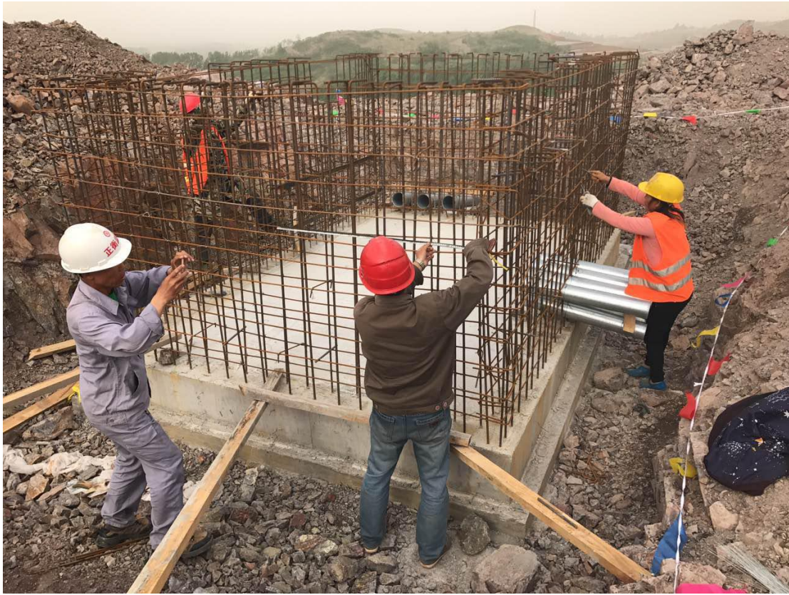
箱变绑扎钢筋验收
