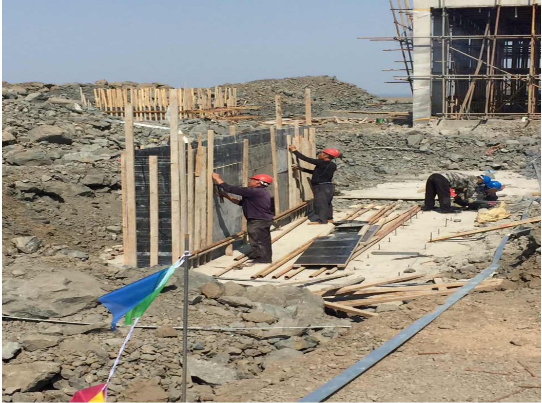
主变基础支模
