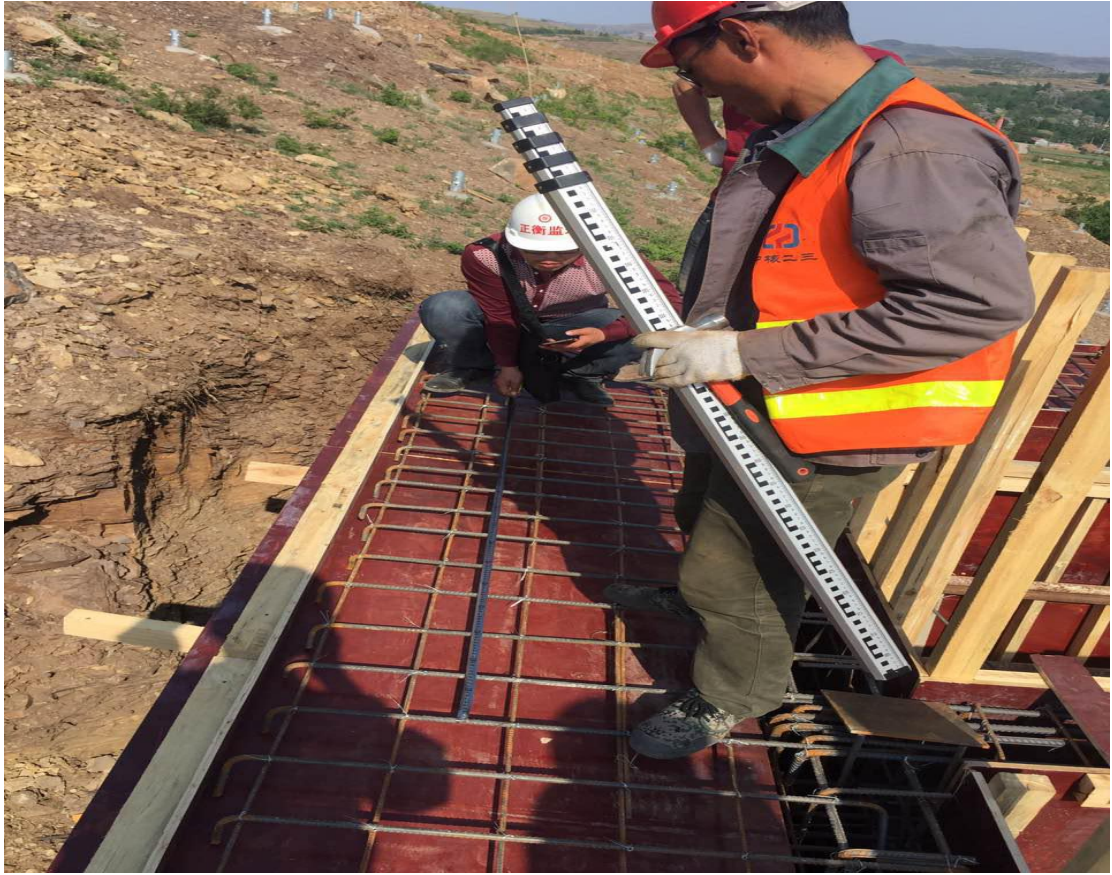
集电线路塔基浇筑
