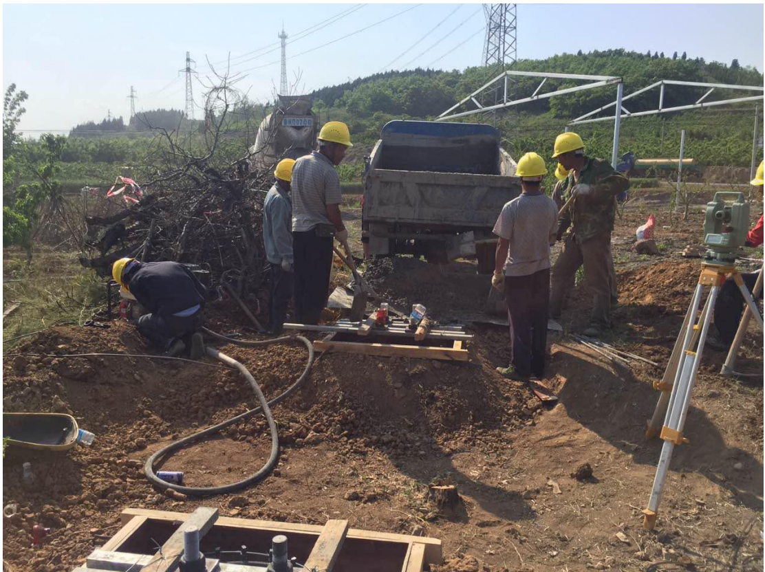
集电线路塔基浇筑
