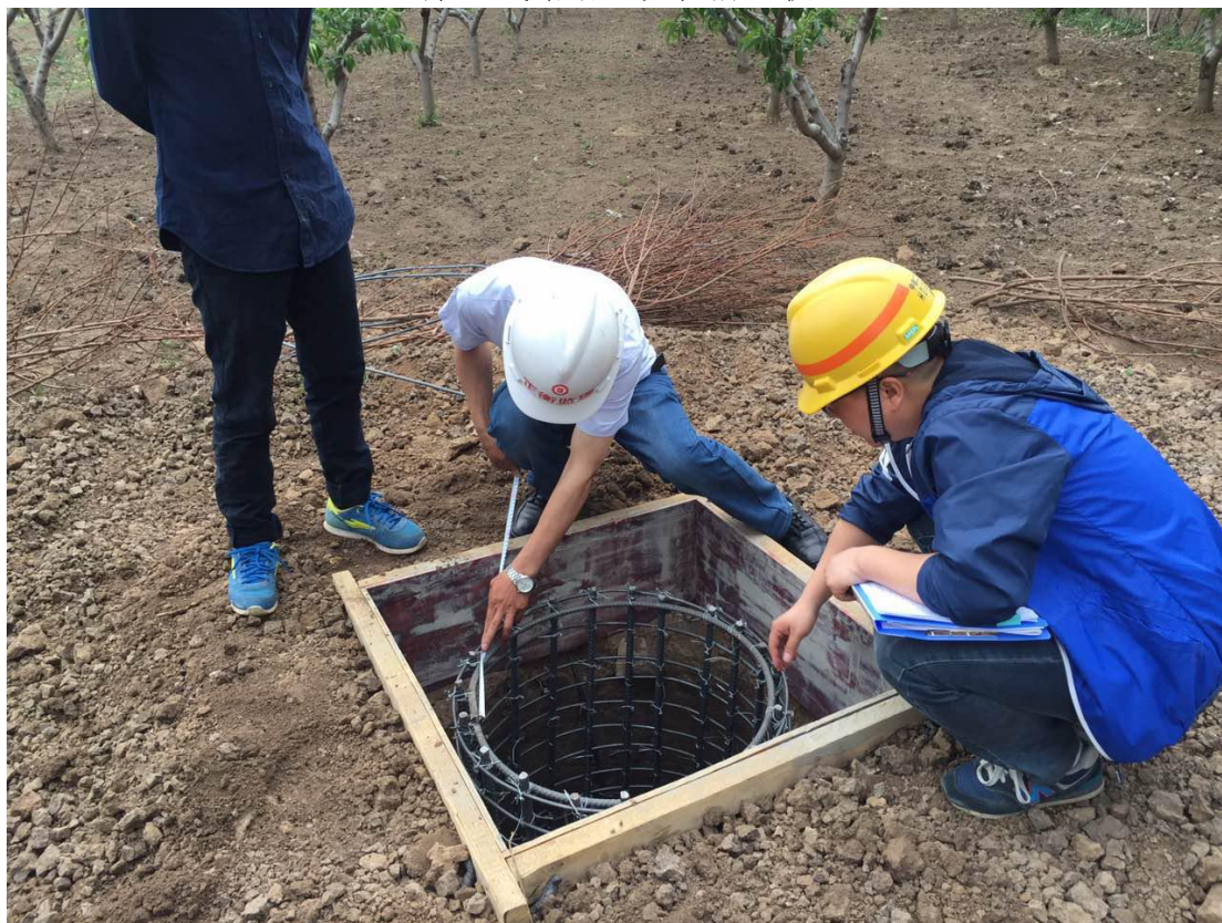
集电线路塔基浇筑前验收
