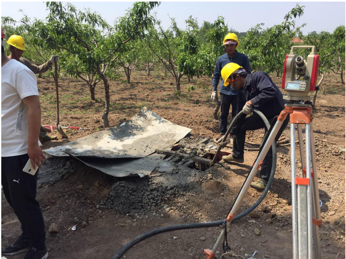
集电线路塔基浇筑
