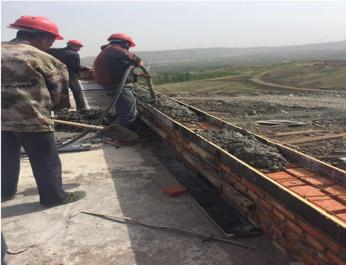
配电楼室内设备基础支模
