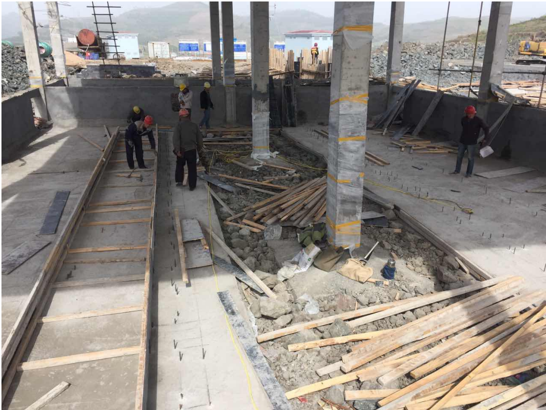
配电楼室内设备基础支模
