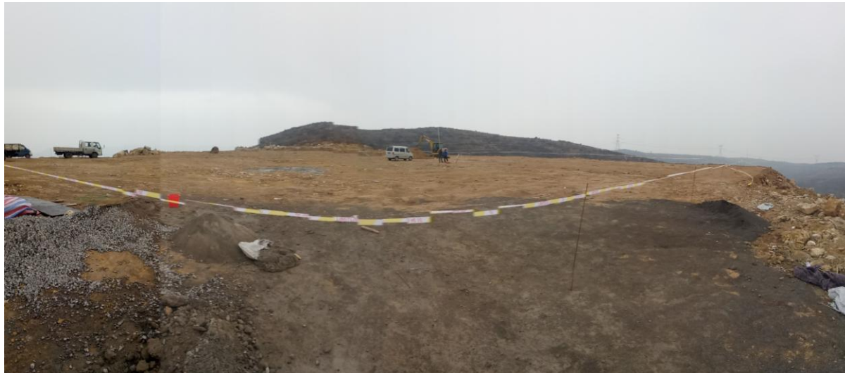
升压站基础开挖
