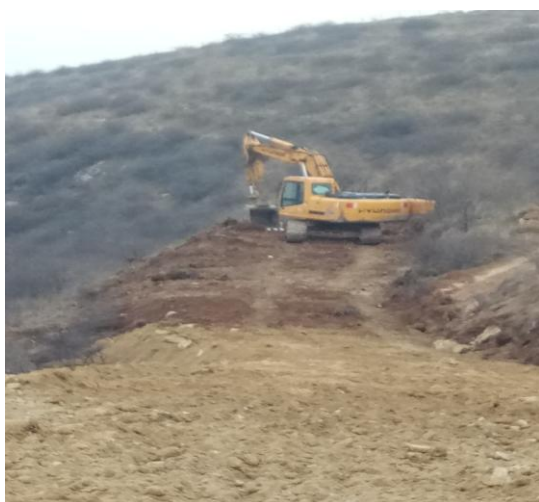
道路基础施工
