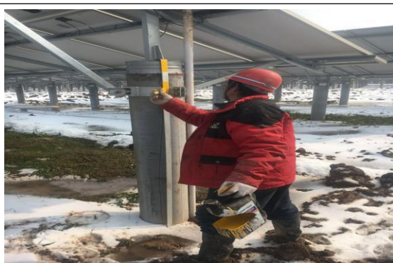
二期 B03 区刷接地标识漆
