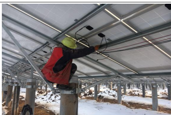
二期 B13 区组件 MC4 头压接
