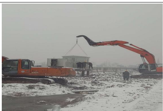
二期二期箱逆变就位安装
