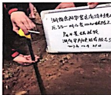
16 基土方开挖验收
