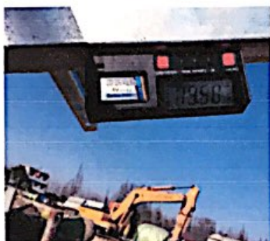
35 区支架安装角度测量
