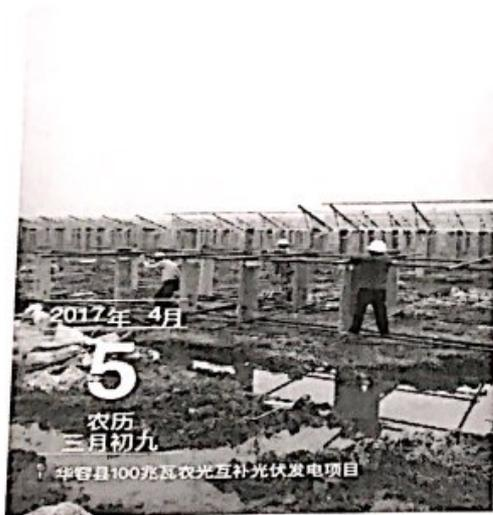
光伏区箱逆变钢构基础搭设
