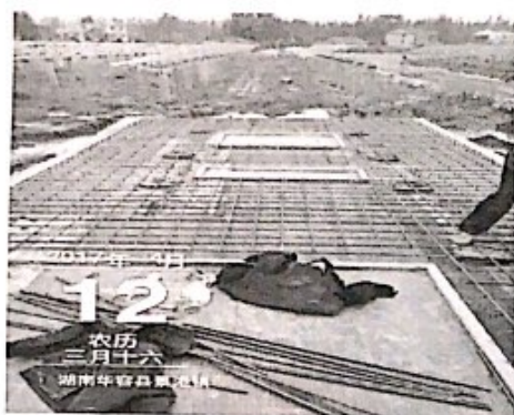
箱、逆变基础平台钢筋绑扎
