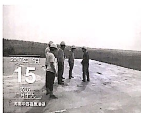
配电楼屋面检查
