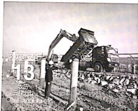
场区道路铺筑
