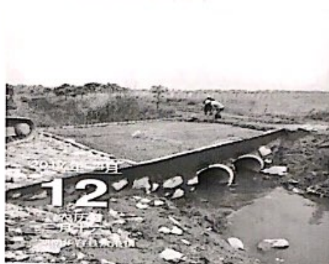
过大渠路段涵管浇筑
