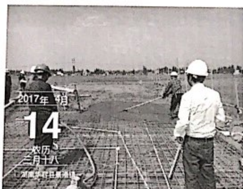
配电楼屋面浇筑
