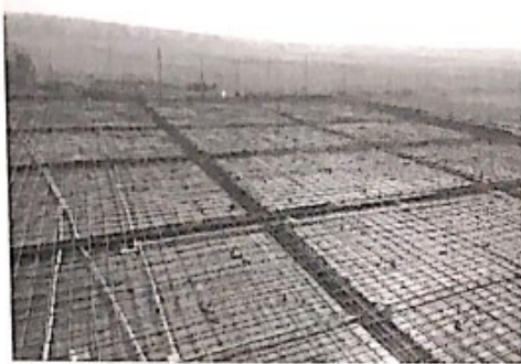
配电楼屋面管线施工
