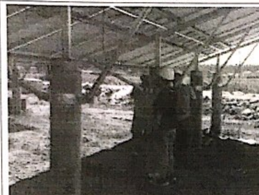
桩头防腐施工质量检查
