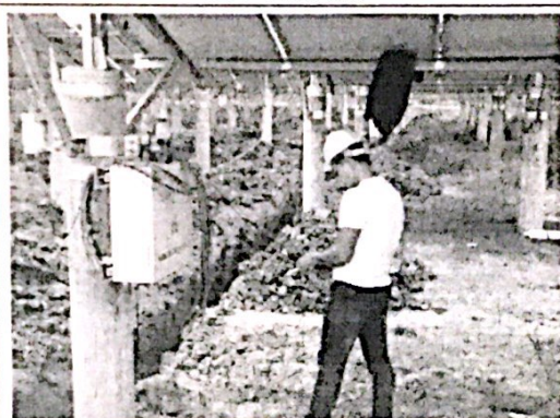
A07 区汇流箱接线
