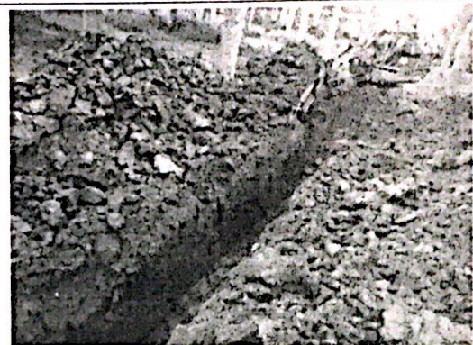
A06 区电缆沟开挖
