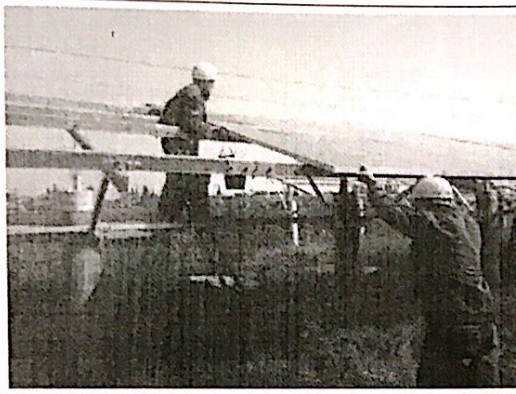
A12 区组件安装
