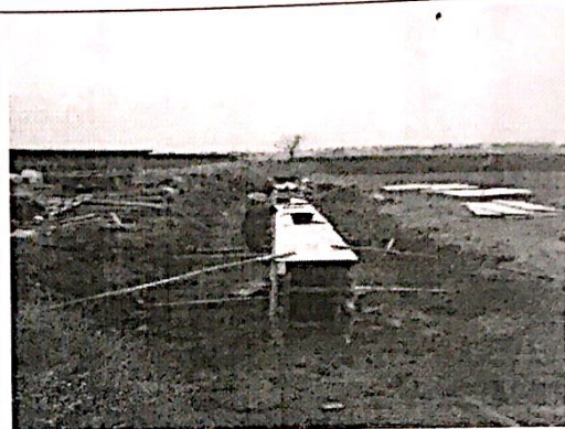
二期场内道路涵桥施工
