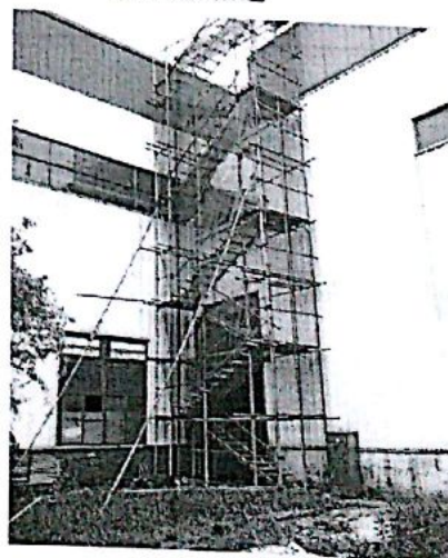
临时爬梯搭建
