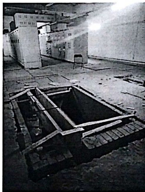
设备基础施工
