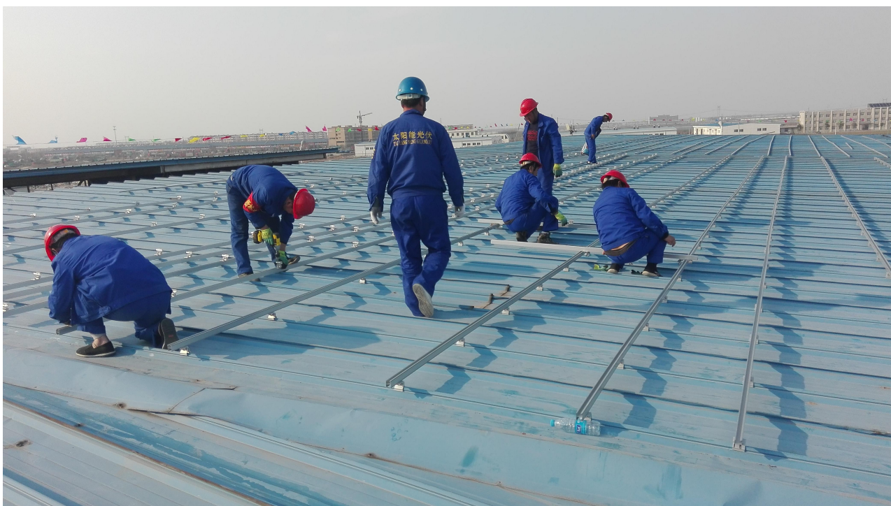
D4-2 理货区工人正在支架安装。
