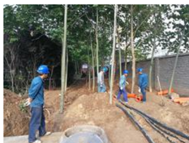
外线电缆敷设
