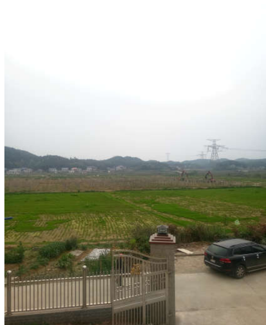
（光伏区打桩施工）
