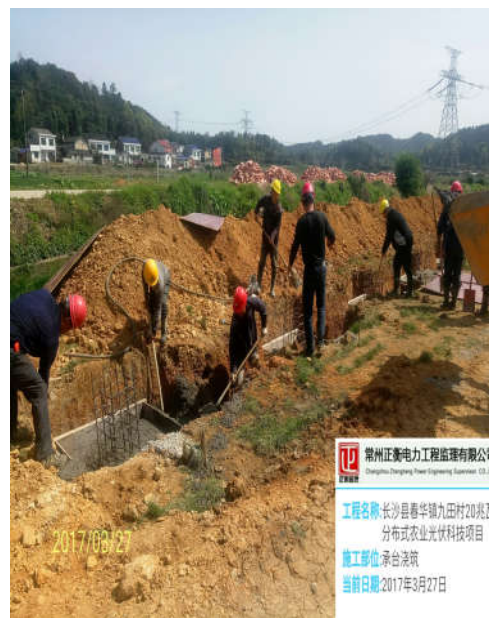
（大棚基础承台浇筑）
