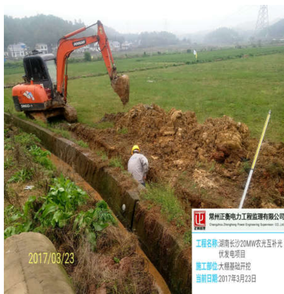
（大棚基础开挖施工）
