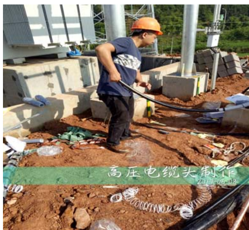
（高压电缆头制作）
