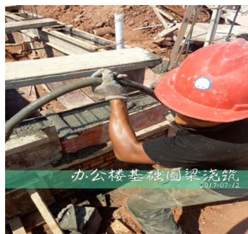
（混凝土浇筑）
