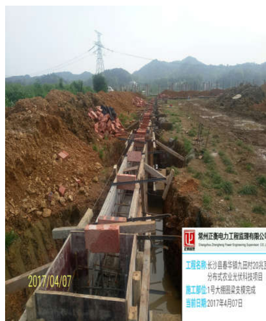
（大棚支模施工完成 30%）
