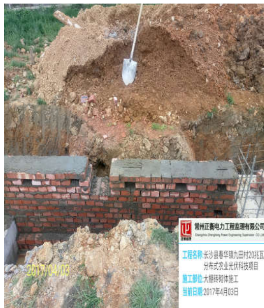
（大棚基础砖砌体施工）
