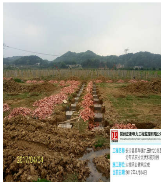
（大棚基础承台浇筑完成）
