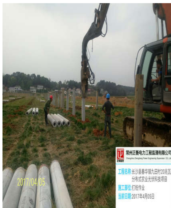
（光伏区打桩施工）
