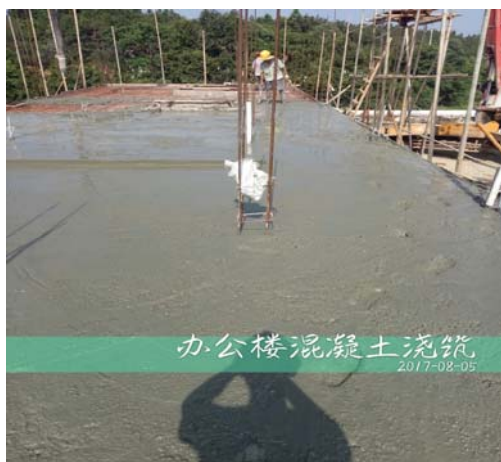
（混凝土浇筑）
