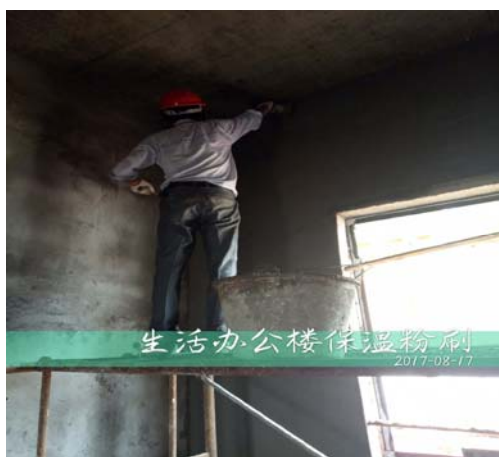
（保温材料安装）
