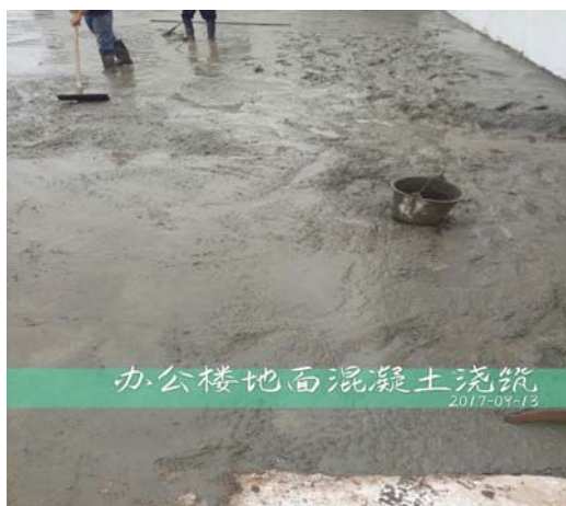
（混凝土浇筑）
