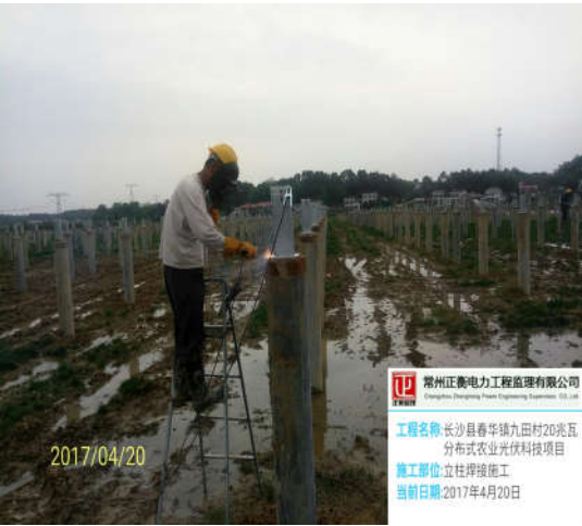
（支架立柱焊接）
