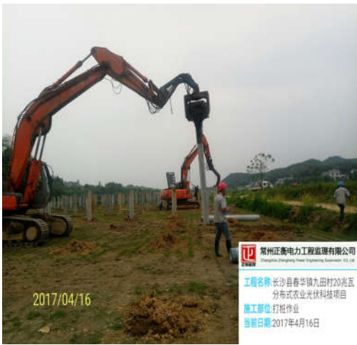
（光伏区打桩施工）
