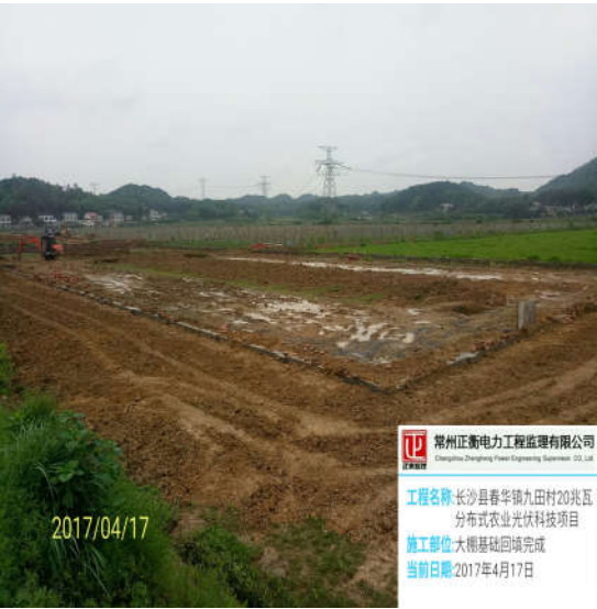
（联排棚基础回填完成）
