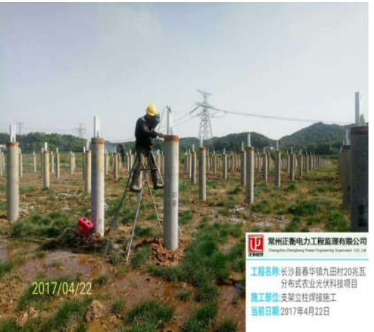
（支架立柱焊接）
