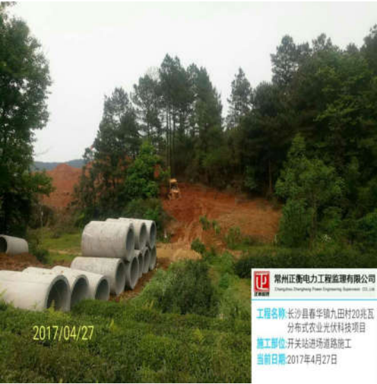
（开关站进场道路施工）
