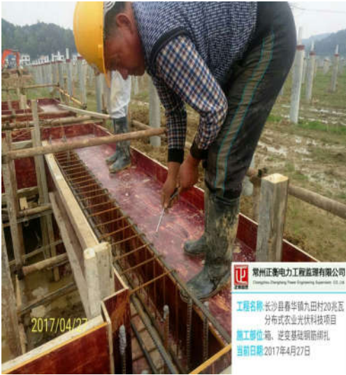
（箱、逆基础钢筋绑扎）
